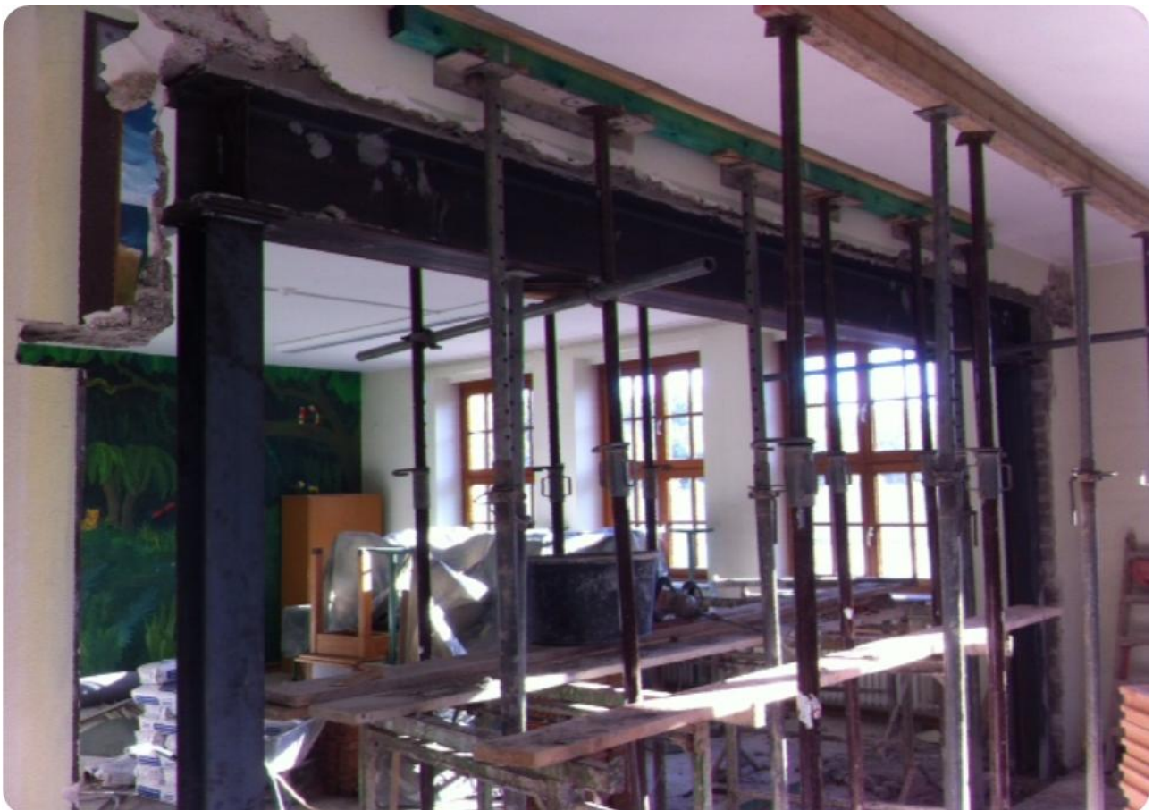
Der Kunstraum 2 im Bau (mittlerweile schon genutzt)
