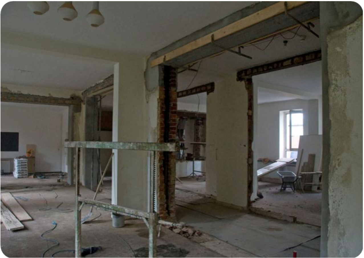
Ein Blick in die zukünftige Cafeteria/Mensa
